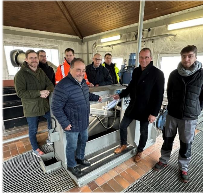
VG-Bürgermeister Jörg Lempertz (vorne; 2. v. l.) und VG-Bürgermeister Alfred Schomisch (vorne; rechts) begutachteten mit ihren Mitarbeitern die Neuerungen in der Zentralkläranlage Mendig. Foto: VG-Verwaltung Mendig/Stefan Pauly
