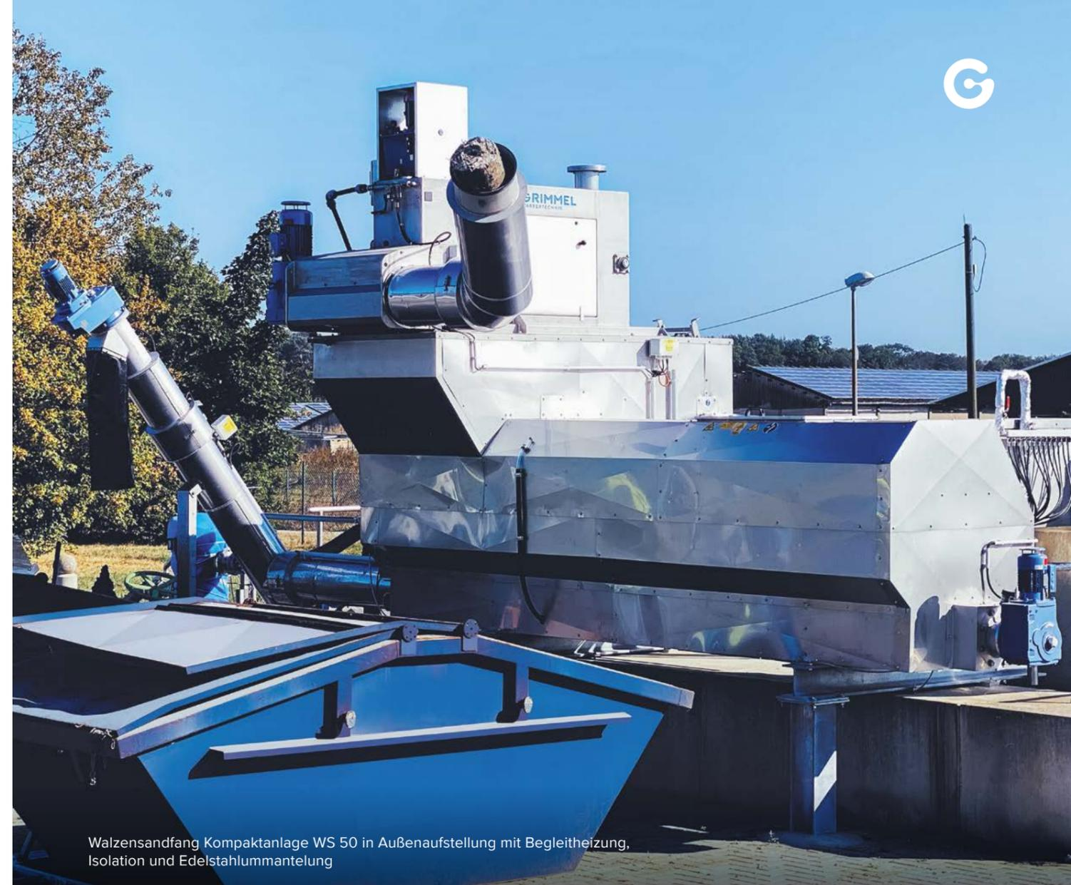
Walzensandfang Kompaktanlage WS 50 in Außenaufstellung mit Begleitheizung, Isolation und Edelstahlmantelung
