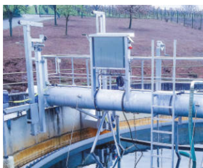
Räumer – als Rund- oder Längsbeckenräumer zur Räumung von Bodenschlamm, Sand und Schwimmstoffen.
