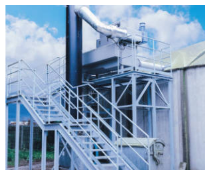
Stahlbaukonstruktionen und Podeste
